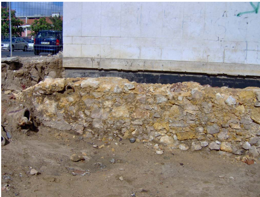
Figuras 5 e 6 – Alicerce descoberto, assente em antiga praia. Fonte: Intervenção arqueológica de 2008, dos autores.
