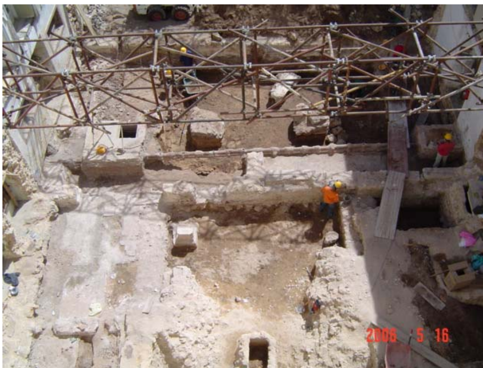
Figura 1 - Escavação manual do lote. Fonte: fotografia dos autores
