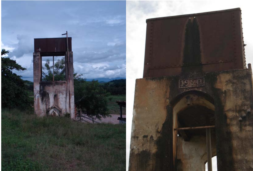
Figura 4. e 5. Caixa d'água, Fazenda Quartéis; Cambuci, RJ. Fonte: Foto da autora.
