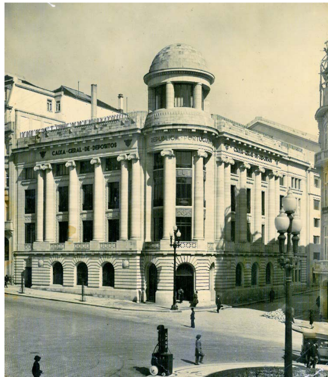
Figura 2. Edifício Caixa Geral de Depósitos/ Filial do Porto inaugurada em março de 1931. Fonte: Arquivo Fotográfico, Caixa Geral de Depósitos.
