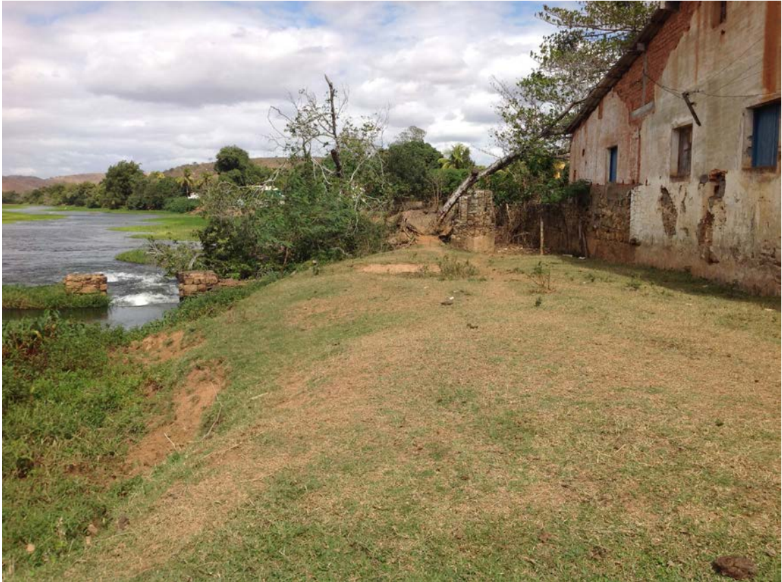
Figura 11. Visão geral do local da antiga roda d'água, Italva, RJ. Observe-se à esquerda parte da murada da represa que desviava a água para a roda. Fonte: Foto da autora.
