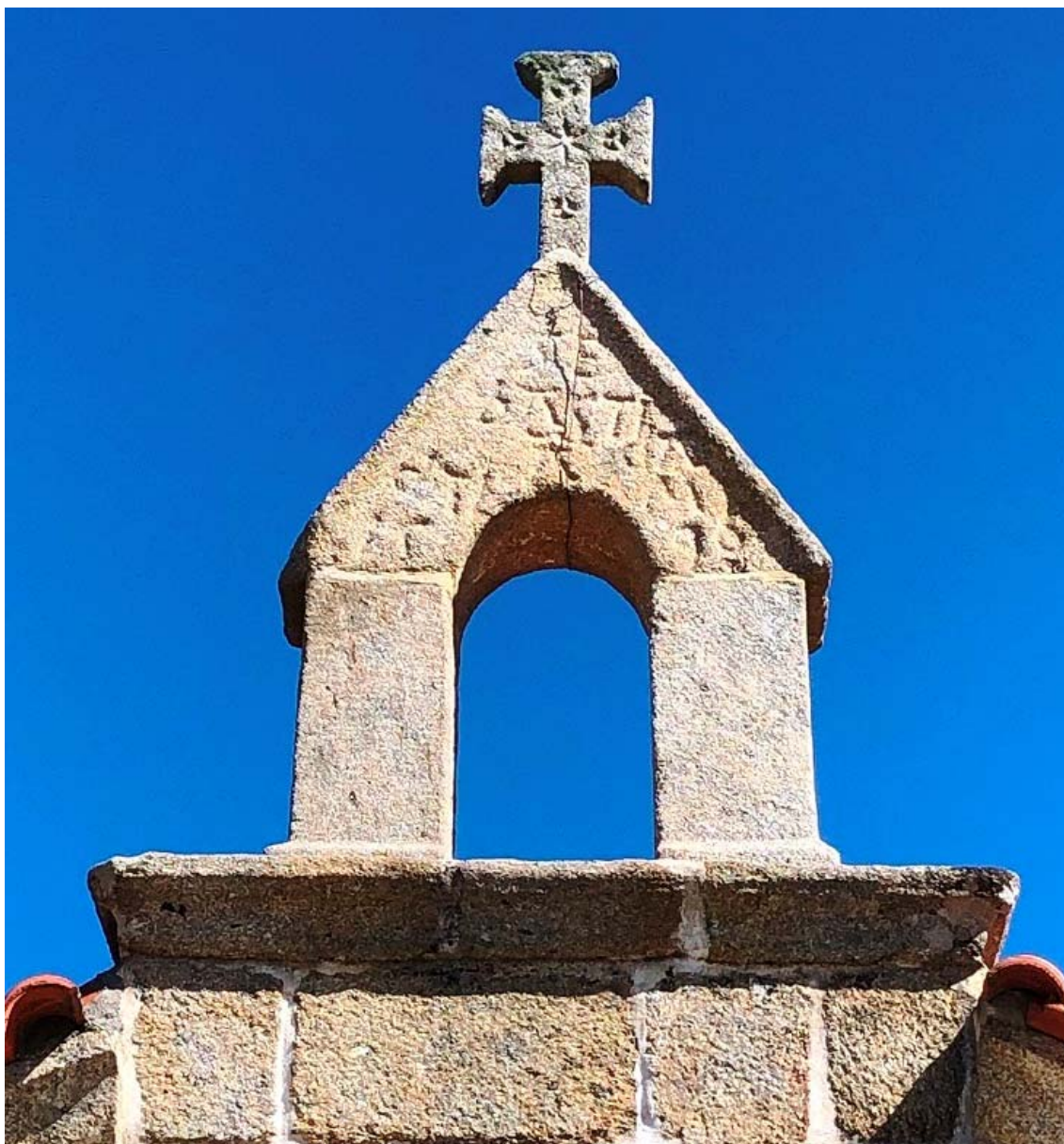
Figura 2 – A torre Sineira. Fonte: JCSantos
